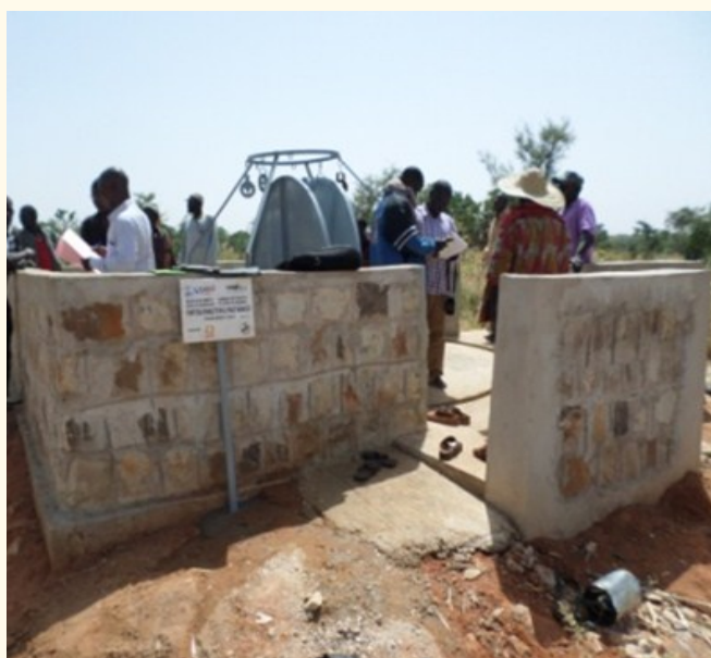
Puits moderne réhabilité à Nounou (Cercle de Bandiagara)
